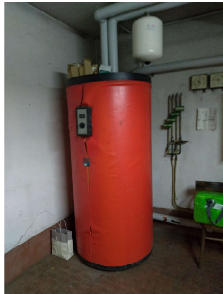
Fig. 2 – serbatoio accumulo acqua calda sanitaria con scambiatore interno
